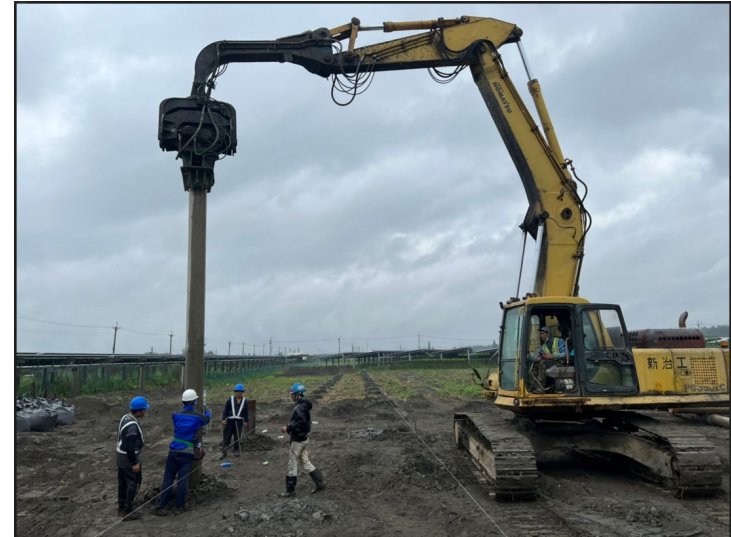
先鑽孔後進樁 減少噪音及震動
