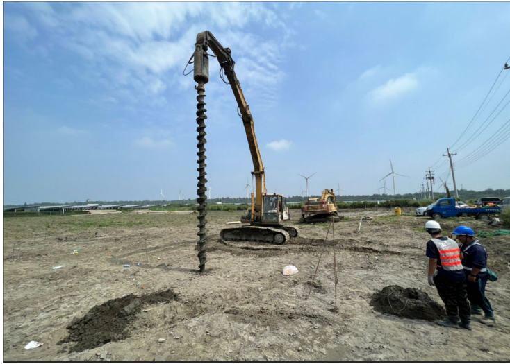
先鑽孔後進樁 減少噪音及震動
