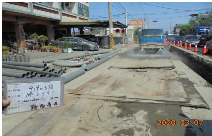
道路鋼板臨時鋪設 灑水以防空氣汙染
