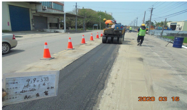
道路瀝青回填,確保路面平整
